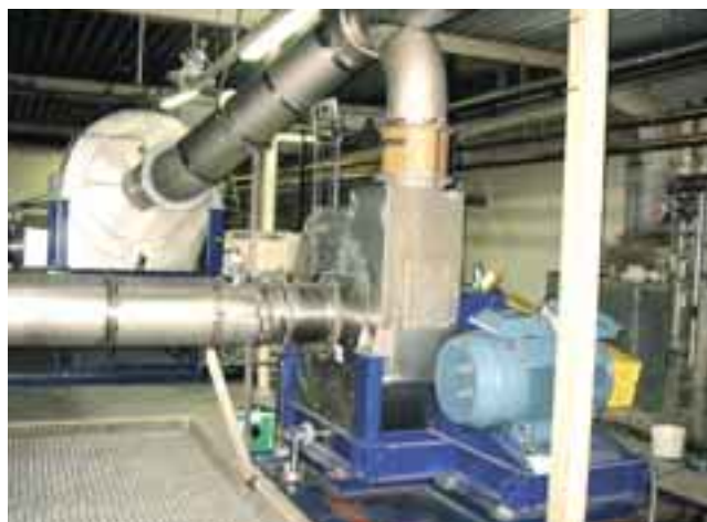
Modernisoitu puhallin testiajossa HOFF Norske Potetindustrier AB:n tehtaalla Brumunddalissa, Norjassa.
